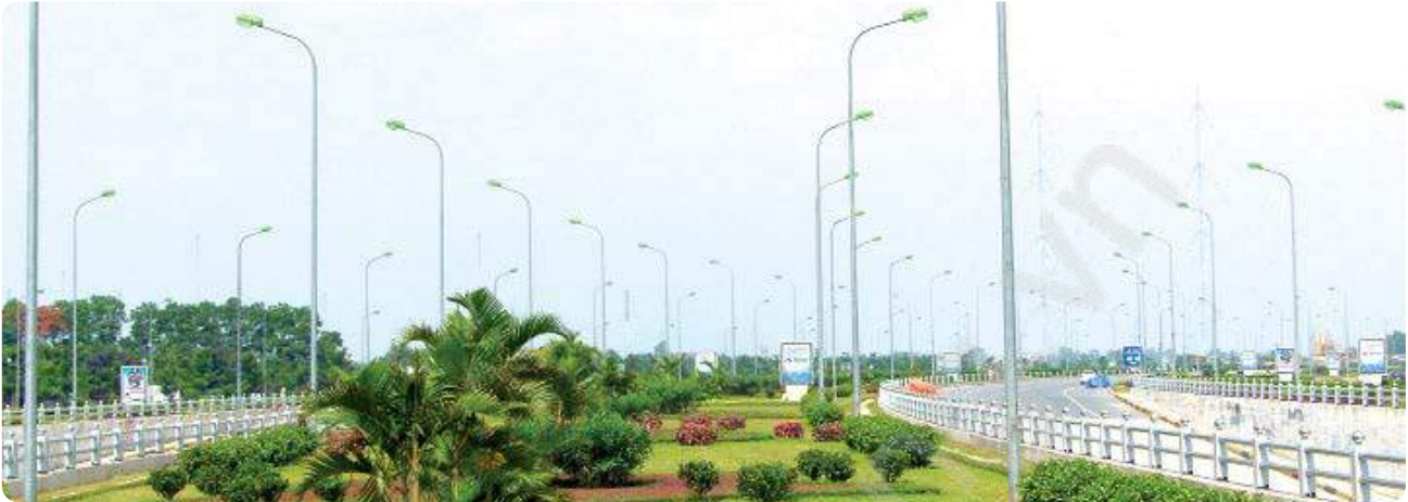
Ống BFP được sử dụng trong hệ thống chiếu sáng đường Láng - Hoà Lạc BFP are used in the lighting System on Lang - Hoa Lac Road
