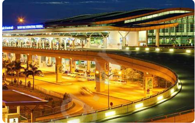
Hệ thống cáp ngầm tại các sân bay Underground cable system in airports
