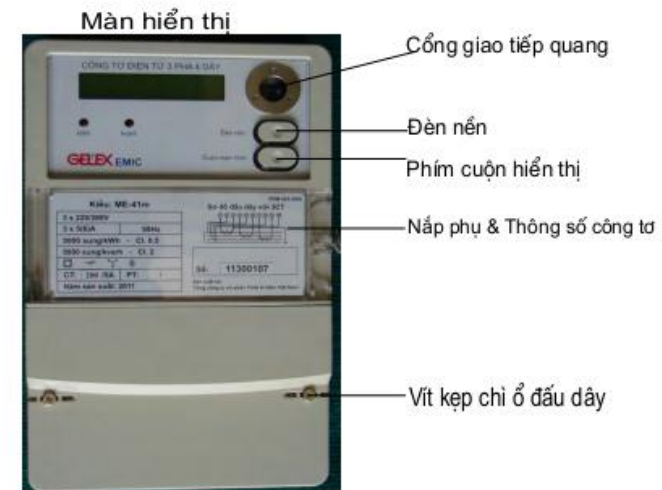
Cấu tạo mặt trước của Công tơ
